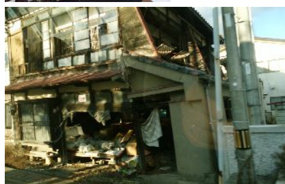
破壊された住宅はそのまま(富岡町)
